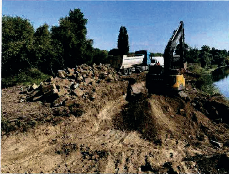
Lors du désenrochement de la rive droite du Doubs.
